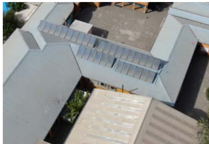
Instalación paneles solares Colegio Moisés Mussa
