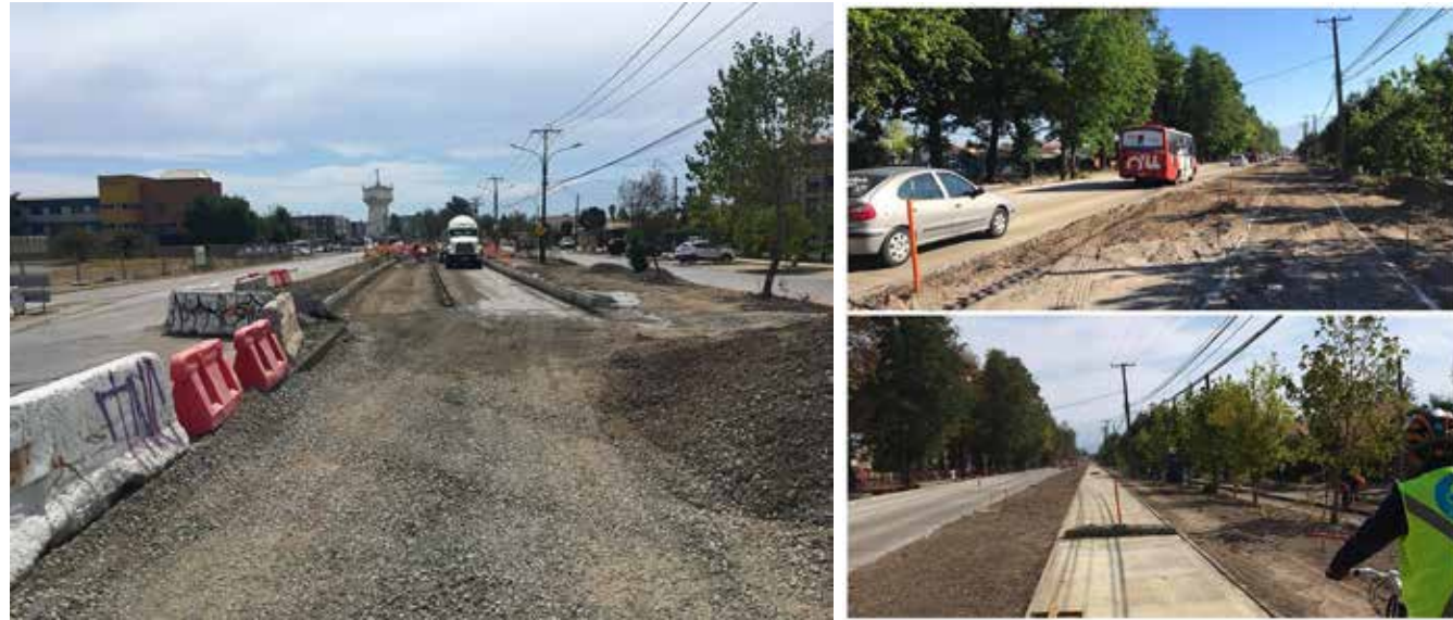
EJECUCIÓN MEJORAMIENTO AVENIDA KENNEDY
