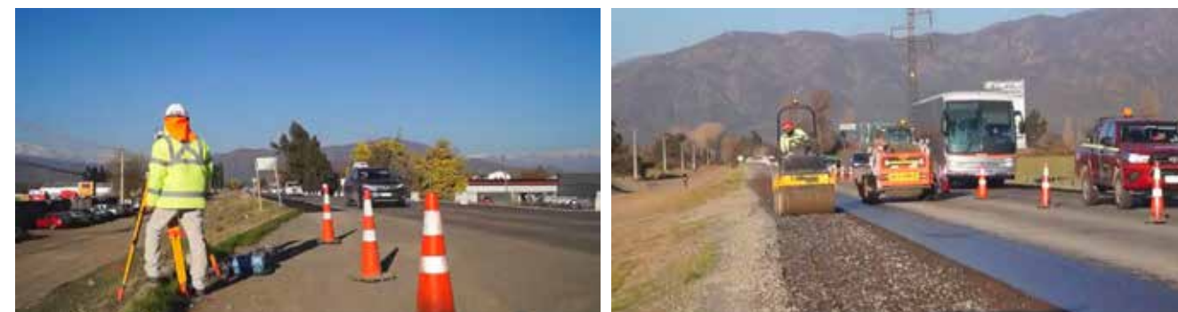
EJECUCIÓN CONSERVACIÓN CARRETERA EL COBRE, RUTA H-27, SECTOR RANCAGUA – MACHALÍ, REGIÓN DE O'HIGGINS
