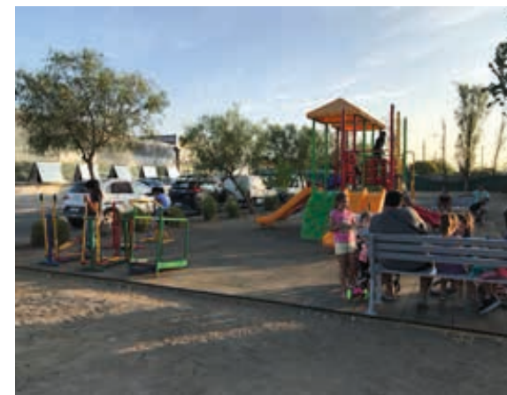
INSTALACIÓN DE BANCAS, SET MÁQUINAS INFANTILES EN PARQUE LOURDES
