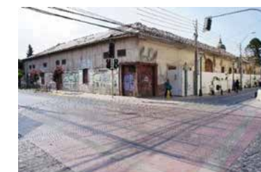
Calle Estado antes
