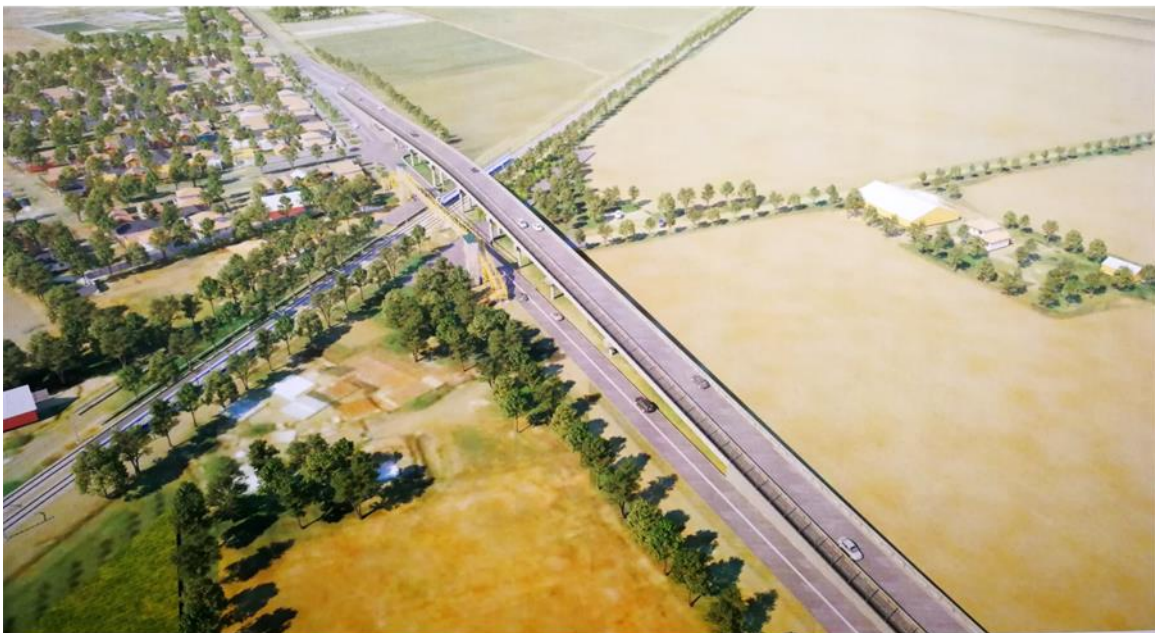
Figura N° 28: Vista hacia el sur poniente del proyecto de Paso Desnivelado Las Coloradas.
