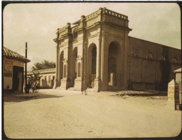
Fachada de la Iglesia de San Francisco en calle Cachapoal
